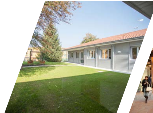
Centro L'Aurora, Gozzano (Italia) L'Aurora Centre, Gozzano (Italy)
